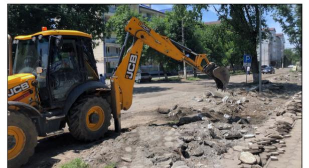
Здесь уже проведен демонтаж старых элементов благоустройства, а также обрезка аварийных деревьев. В данный момент активно ведется работа по расчистке площадок для дальнейшего устройства парковочных зон.
